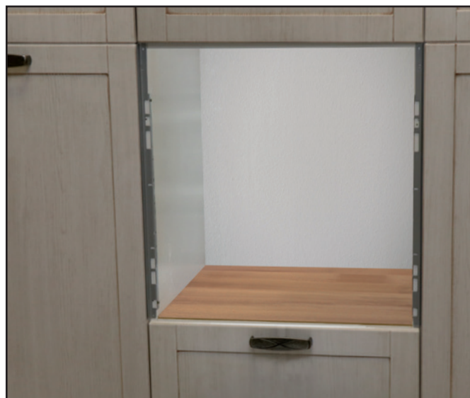
Prostor pro troubu s namontovaným tepelným štítem
