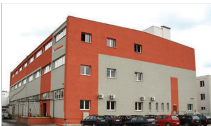
Główny magazyn przy ul. Batalionów Chłopskich
