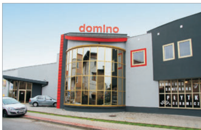
Biuro przy ul. Rzeźniczej
